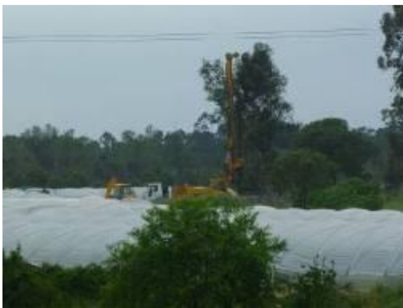
Construcción de un pozo denunciado por WWF
